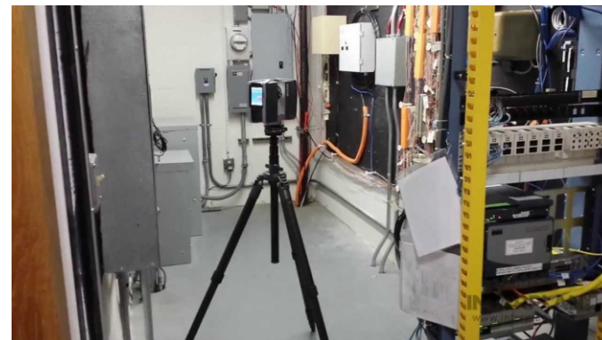
Verifica interferenze impianti in ATP
