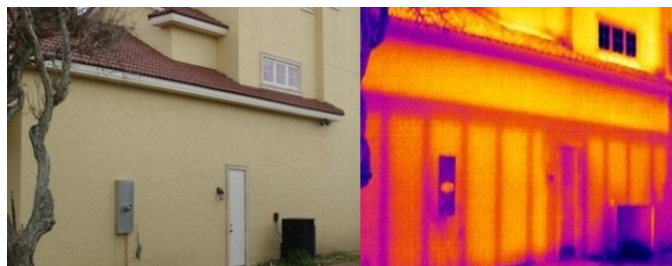
Rilievo termografico per contenzioso legale sugli isolamenti
